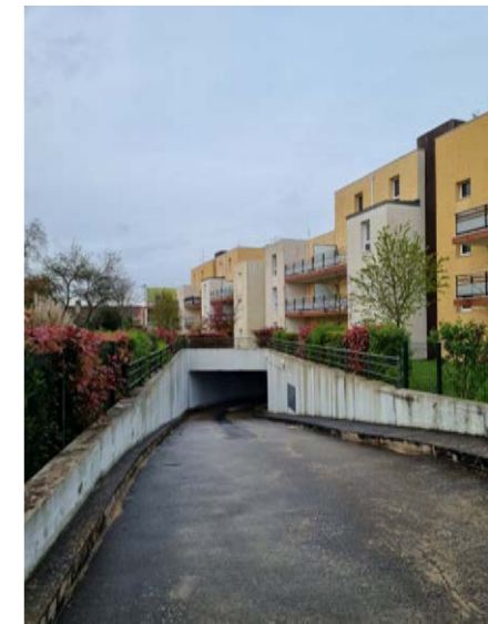
Le parking sous-terrain
