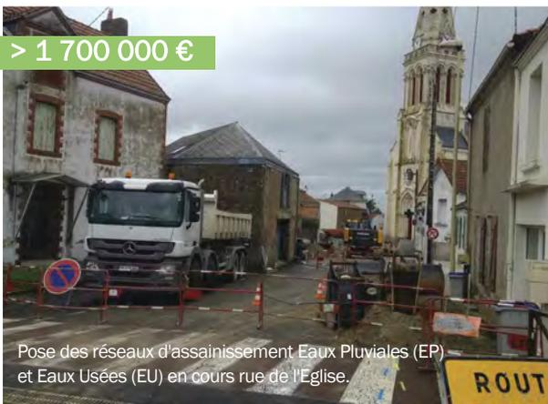
Pose des réseaux d'assainissement Eaux Pluviales (EP) et Eaux Usées (EU) en cours rue de l'Eglise.
