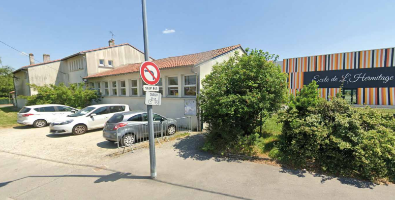
Le bâtiment actuel - Vue de la rue de la Jouardais
