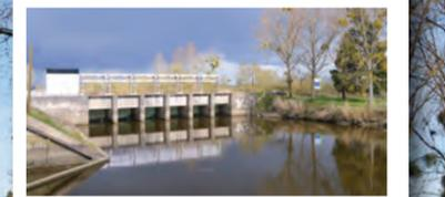
Ce pont-barrage, construit en 1960, fait partie du système d'irrigation et de régulation des marais du Sud-Loire. Il permet l'échange des eaux entre le marais et la Loire, en particulier pour évacuer les eaux du lac de Grand-Lieu en hiver. Il est construit au carrefour d'une rivière, l'Acheneau, et du Canal de la Martinière. > Panneau explicatif sur place.
